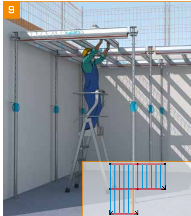
- Avancer les poutrelles secondaires de proche en proche.
