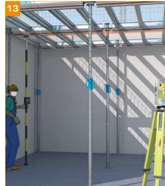
- Affiner la mise à niveau à l'aide d'un niveau laser ST par ST. - Une pige suspendue au coffrage permet à 1 seul homme d'effectuer le réglage au laser. Effectuer un dernier contrôle du verrouillage des têtes à cette étape.
