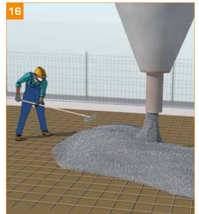
- Réalisation de la dalle béton. → Répartition du béton sur le coffrage sans surcharge des poutrelles et ST.
