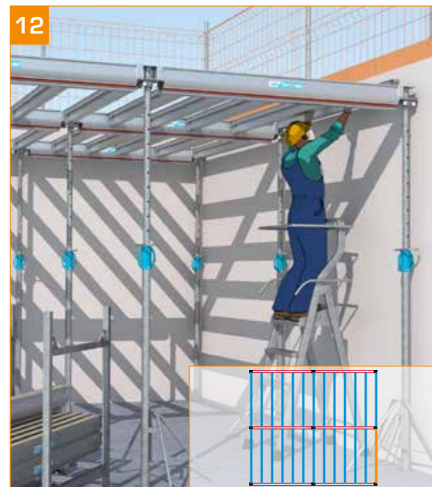
- Terminer la mise en place des poutrelles secondaires.
