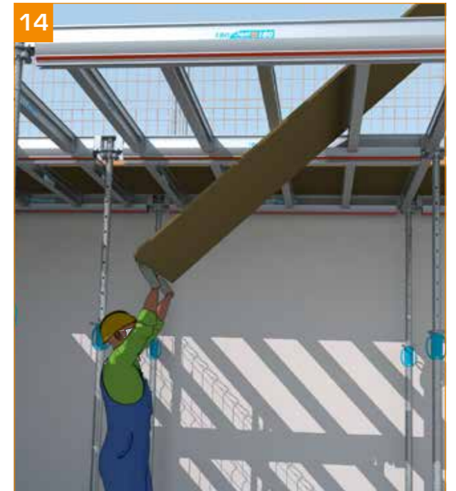
- Quand la structure est terminée et réglée en hauteur : mise en place du CP. - Utilisation de la servante pour le découpage du CP (voir Accessoires p. 10). → Sécurité périphérique (voile, poutre...) réalisée au préalable.
