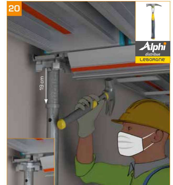
20 - Décoffrage de la dalle : décentrer les têtes coffrantes des ST à l'avancement. - Les poutrelles primaires et les panneaux Éco+ descendent de 19 cm. - Les ST restent en place.
