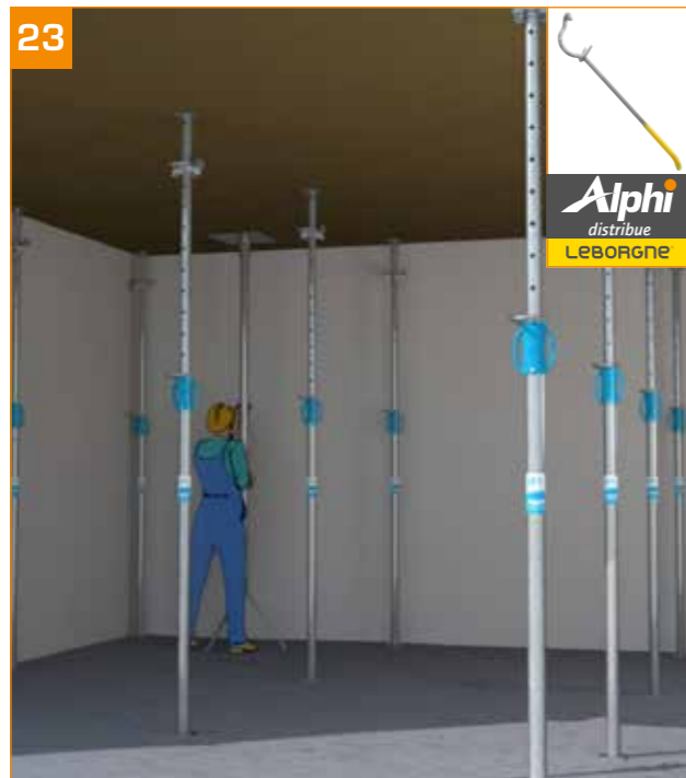
23 - Décoffrage de la dalle : enlever les étais placés en périphérie des cellules. - Laisser en place pendant 3 jours minimum les autres étais (selon type de béton et température extérieure).
