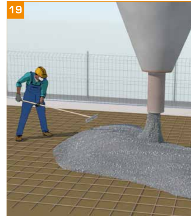
19 - Réalisation de la dalle béton après ferrailage et mise en place des incorporations. → Répartition du béton sur le coffrage sans surcharge des poutrelles et ST.
