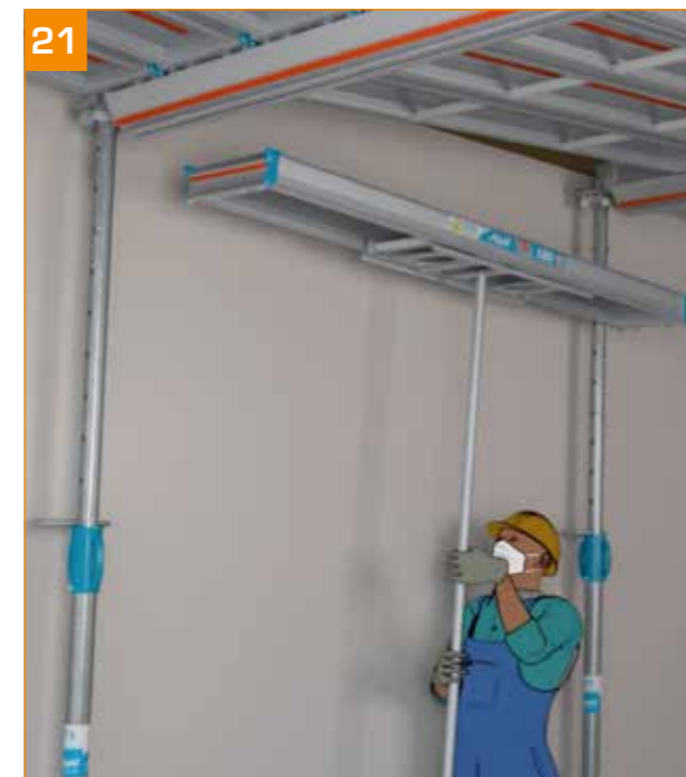
21 - Décoffrage de la dalle : enlever les panneaux Éco+ à l'avancement à l'aide de la TopPerche Éco.
