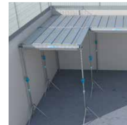
Les poutrelles extensibles permettent de se rapprocher des bords de la cellule
