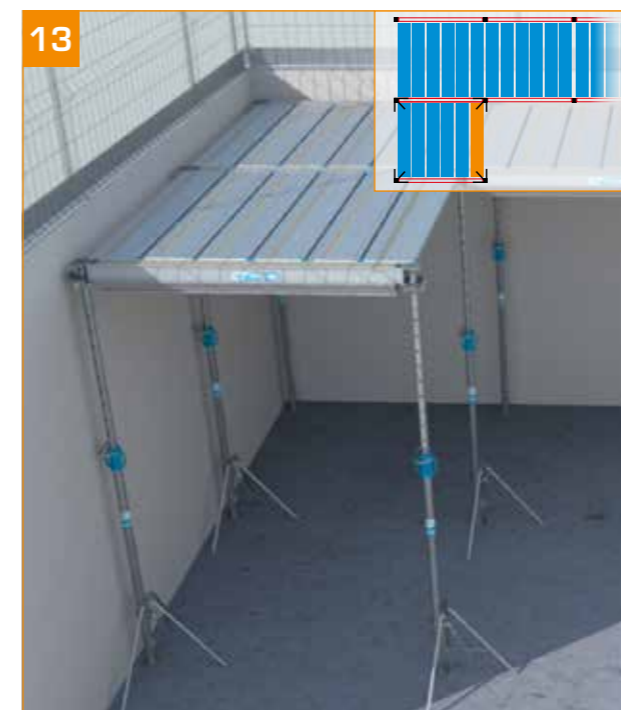
13 - Reprendre la mise en place des panneaux Éco+.
