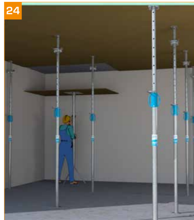
24 - Utiliser un lève-plaque pour retirer le CP.
